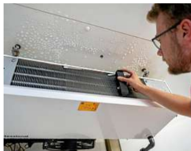
Hier wird ein von Coldsense entwickelter Sensor (in schwarz) an einen Wärmetauscher gehängt. In Kühlhäusern vereisen diese Anlagen oft – das kostet viel Energie.
